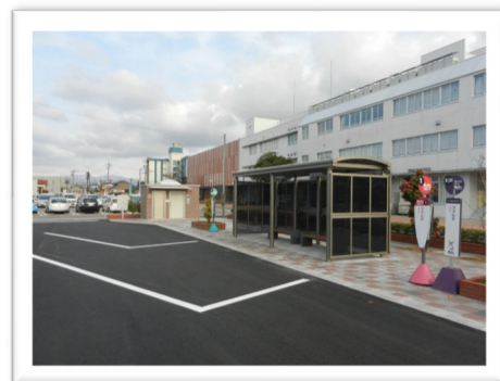
▲ 交通広場の整備（野々市小学校北側）
