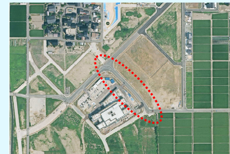
▲ （都）野々市中央公園西線の整備
