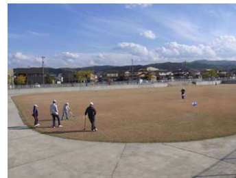
雨水調整池を緑地として利用 （粟田6号緑地）
