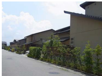
緑化が進められている 住宅地 (末松ガーデンアイル)
