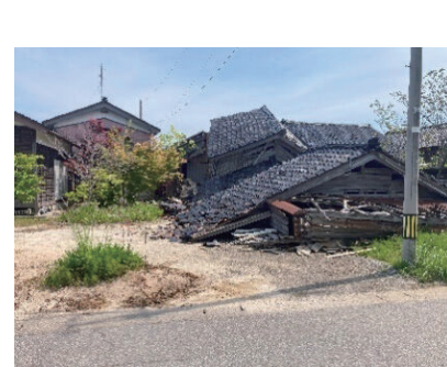
耐震化されていないため 倒壊した建物
