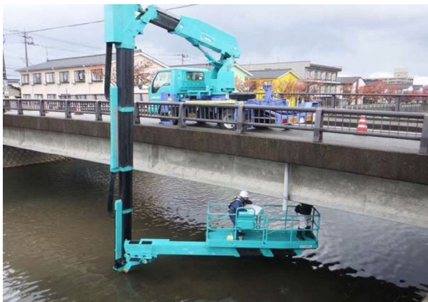
近接目視点検の例（左：橋梁点検車による点検、右：高所作業車）
