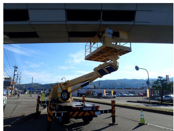
近接目視点検の例（左：橋梁点検車による点検、右：高所作業車）
