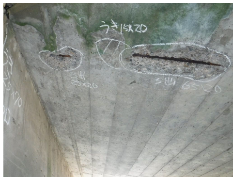
コンクリート主桁の鉄筋露出
