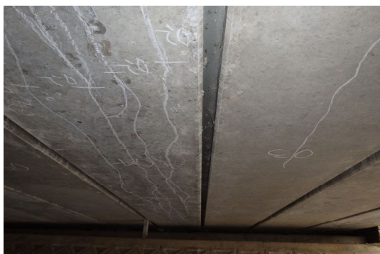
橋桁下面のひびわれ
