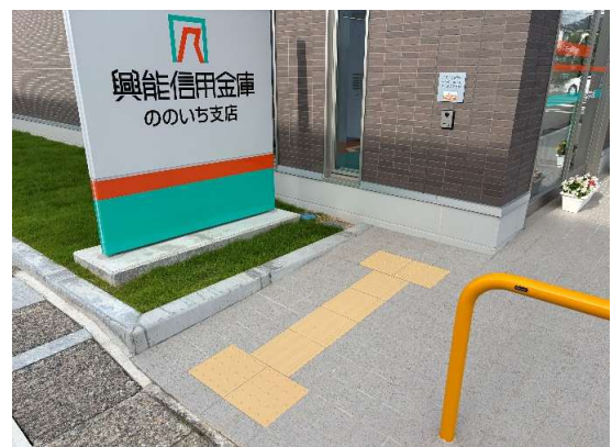
視覚障害者誘導用ブロック
