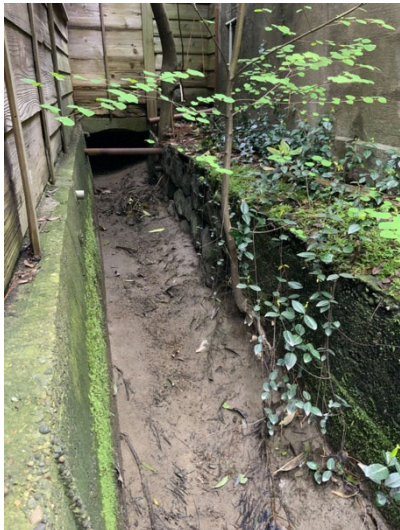
写真 31 便所脇水路護岸 カツラ
