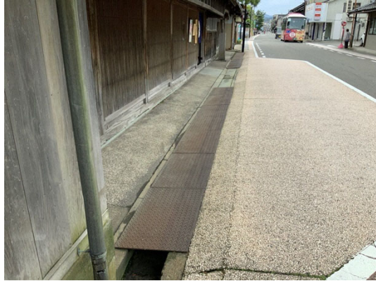
写真 28 南側道路と側溝
